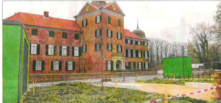
Die Kassenhäuschen stehen schon an den Eingängen am Schloss und an der Oldenburger Landstraße/Süduferpark.
