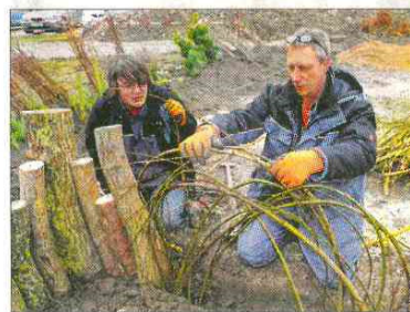
Markus Weisbrich (r.) und Marcel Wulf stellen eine Faschine her.
