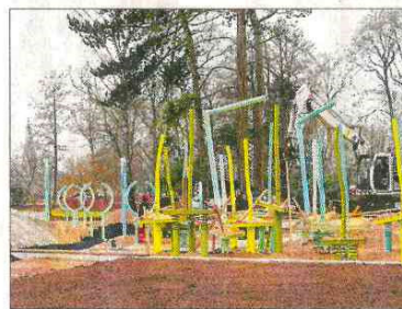
Der Wackelwald im Seepark ist so gut wie fertig.
